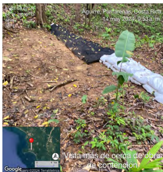
Imagen 8. Vista de obras de retención de suelo.
